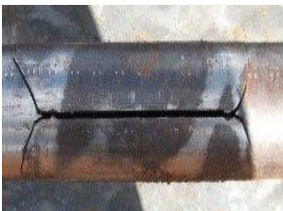
FATIGA – FORMA DE T POR EXCESO DE CARGA DE LA MORDAZA
